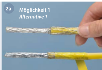
2a Möglichkeit 1 Alternative 1 Schirmgeflecht zurückschieben und mit Isolierband fixieren. Push back the copper braid and fix it with tape.
